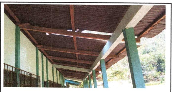
Foto 4: Se observa desprendimiento de láminas.
