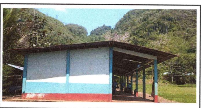
Foto 6: Se observa desprendimiento de láminas.
